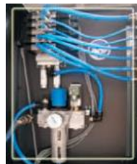
Centrální pneumatika FESTO pro snadnou údržbu
